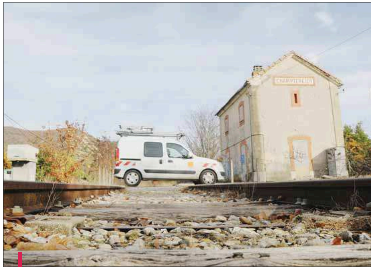
Depuis l'accident d'Allinges (Haute-Savoie) en 2008, les réactivations de lignes doivent prévoir la suppression des passages à niveau. La ligne en compte neuf dont deux sur Digne. /PHOTO ERIC CAMOIN
